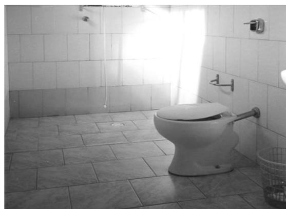
Figura 6 - Exemplo das inadequações das barras
